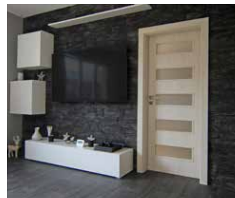
obklad kovové zárubně s novými dveřmi
